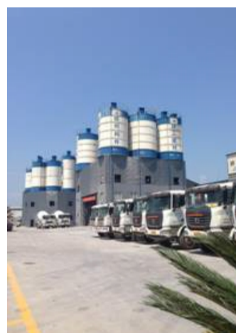
图:杭构·建工建材公司绿色搅拌站基地。
